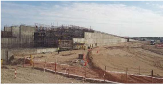
Los muros de contención de concreto armado tienen una longitud de 76 m y están en los laterales externos del inicio de los ramales 1 y 2, en el comienzo de las rampas de acceso.
