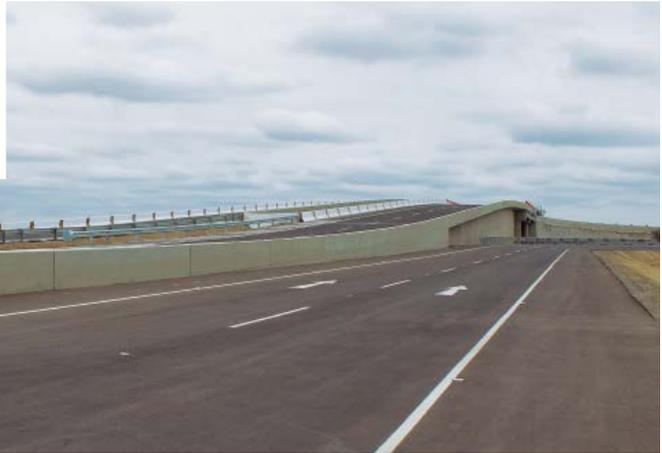
De los cuatro ramales que componen en intercambio vial, los ramales 1 y 2 que cruzan a desnivel la vía Panamericana presentan 510 m de longitud cada uno. El ramal 3, que empalma a nivel con la vía Panamericana, tiene 534 m de longitud y, finalmente, el ramal 4 que ostenta 460 m. En total el sistema tiene alrededor de 2 km de desarrollo.
