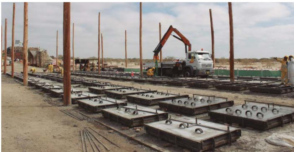
La producción de los paneles de concreto prefabricados se realizó con encofrados metálicos especiales. Se efectuaron cumpliendo las normas técnicas y reglamentos nacionales e internacionales.
