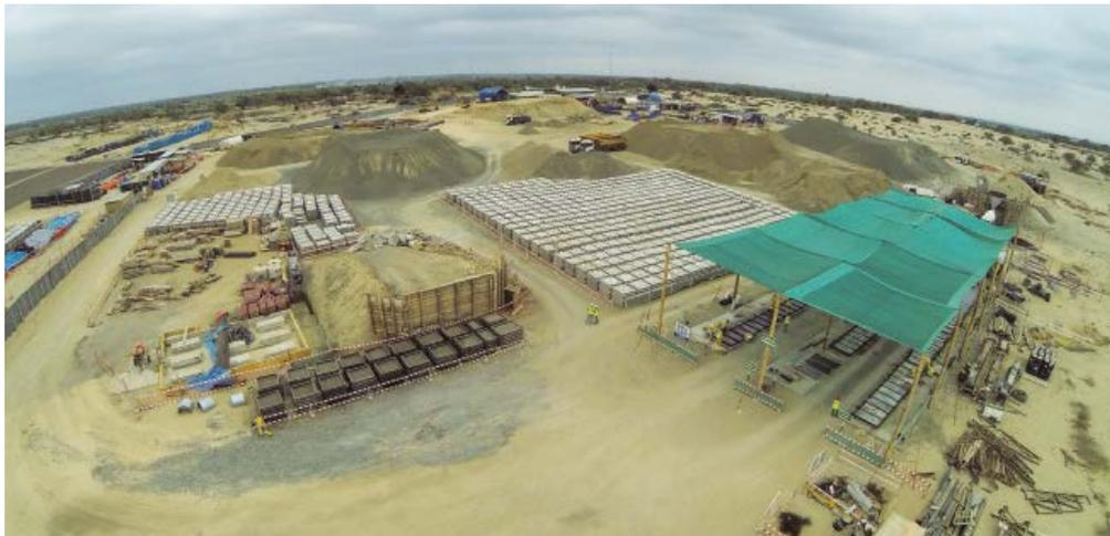
Se instaló un patio de prefabricados para la elaboración de 5,593 paneles de concreto para el suelo reforzado, 492 prelosas para los puentes, 14 vigas AASHTO de 18 m de largo, 14 vigas AASHTO de 25 m de longitud, y 504 unidades de New Jersey.
