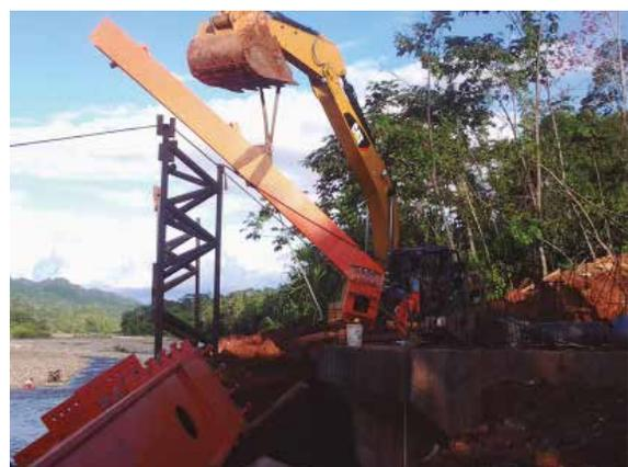
➤ El montaje del arco requirió del empleo de mano de obra especializada y de excavadora para su izaje, ya que no se pudo contar con grúa.
