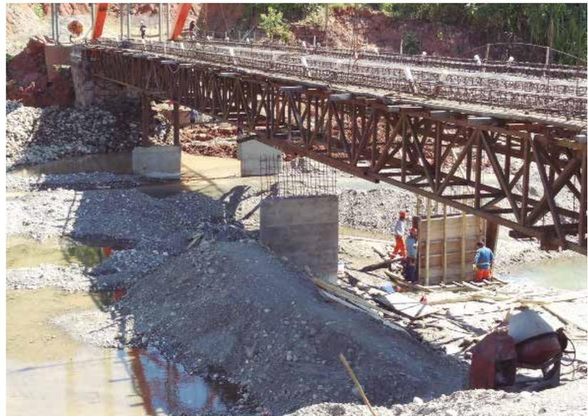
➤ La obra requirió el empleo de celosías de acero sobre el cual se ejecutó la losa y vigas tirantes.
