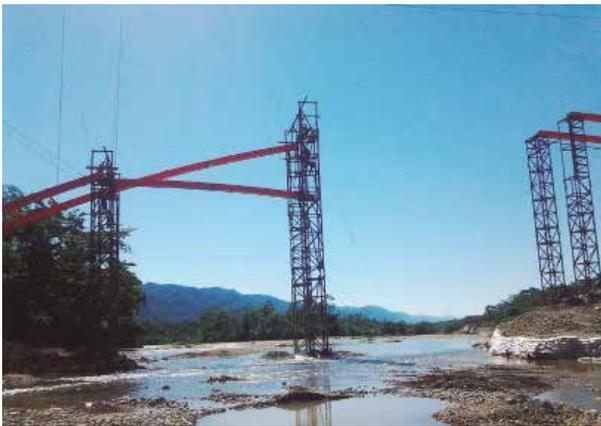
➤ De forma atípica, primero se realizó el arco antes que la losa, para lo cual se erigieron dos torres de montaje con cables de transporte. Primero se ejecutó en la zona donde estaba el relleno y seguidamente en la otra ribera.
