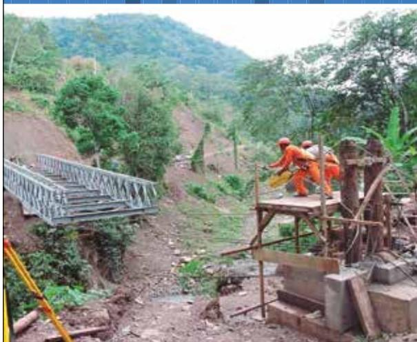
LANZAMIENTO DE ESTRUCTURA POR MEDIO DE CABLES - PUENTE RAMOSPAMPA.
