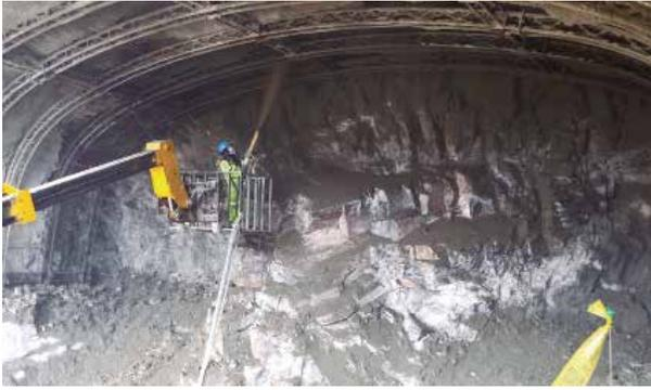
➤ Para el concreto lanzado se especificó una resistencia a la compresión inconfiada a los 28 días de 28 MPa.
