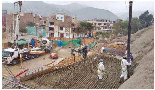
➤ Vaciado de la bóveda del falso túnel.
