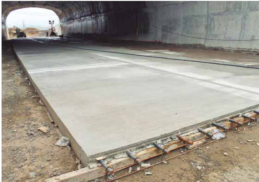
➤ El pavimento rígido de las vías subterráneas posee un espesor de losa de 20 cm.
