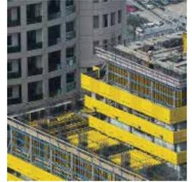
La eficaz plataforma SCP, es el sistema de encofrado modular para núcleos de edificios. En este sistema de encofrado, el sistema de muro y la plataforma de trabajo se elevan a la vez al siguiente vaciado mediante unos pocos potentes cilindros hidráulicos. La unidad de elevación se adapta con gran flexibilidad a plantas complejas. ■
