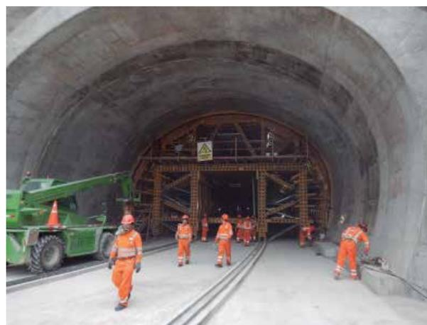
Encofrado rotando a siguiente posición.
