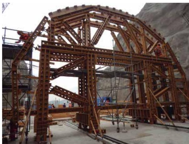
Armado de frames del Super Stud sobre ruedas y rieles.
