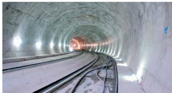
Para el revestimiento interior se utilizó un encofrado deslizante que iba avanzando conforme se vaciaba el concreto.
