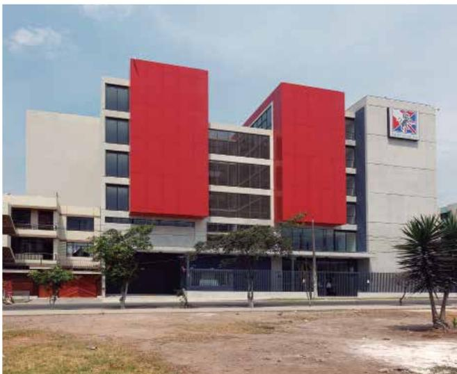
➤ Los volúmenes cerrados de las dos fachadas (delantera y posterior) se encuentran forrados con paneles prefabricados de color rojo; el azul se ha colocado de manera lineal.
