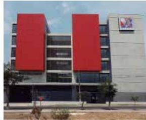
Este producto consta de dos láminas de aluminio recubiertos de bobina que están unidos a ambos lados con un núcleo de polietileno.
