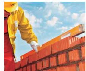
El King Kong es un ladrillo estructural para hacer muros portantes (aquellos que soportan la carga de los techos y esfuerzos laterales F1V. F1M), y en algunos casos y dependiendo del presupuesto también para la construcción de cercos. Este ladrillo tiene la propiedad de "flexotracción" por su capacidad para resistir fuertes movimientos de energía como los ocasionados por los sismos.
