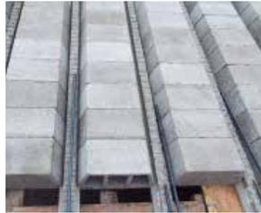
Es un sistema de losas aligeradas que brinda una solución eficiente para el techado de viviendas, oficinas y otras edificaciones.
