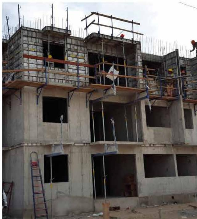
En esa obra de **Constructora MPM**, se utiliza el sistema monolítico de alto rendimiento **Doka OneGo**, diseñado para hormigonar muros y losas rápidamente en un solo vaciado. Sus paneles ligeros de aluminio y una secuencia optimizada de hormigonado aportan una gran eficiencia en la obra.
