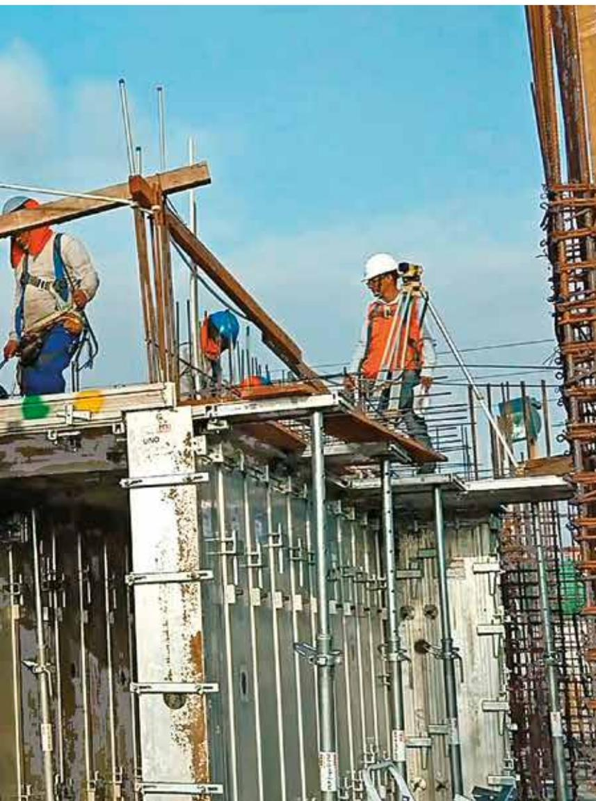
Con la ayuda del sistema de encofrado monolítico **PERI UNO**, nuestro cliente LIVIT ejecuta en Trujillo la construcción de 840 departamentos (área techada de 65 m<sup>2</sup>). El innovador sistema UNO permite industrializar la producción de viviendas, se obtiene altos rendimientos de trabajo, reducción en los tiempos de ejecución, excelente acabado y no requiere gastos en consumibles.
