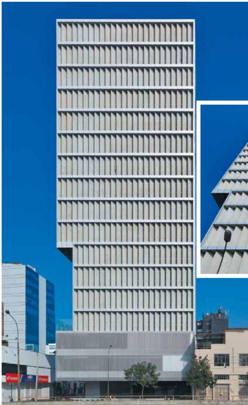
La fachada que mira a la Av. Paseo de la República se trabajó semicerrada, mediante unos parasoles de concreto prefabricado girados en 35° y separados entre sí cada 40 cm. Estos atenúan el ingreso solar en la mañana y redireccionan la vista desde el interior de las oficinas hacia el eje de la vía mencionada y el mar.
