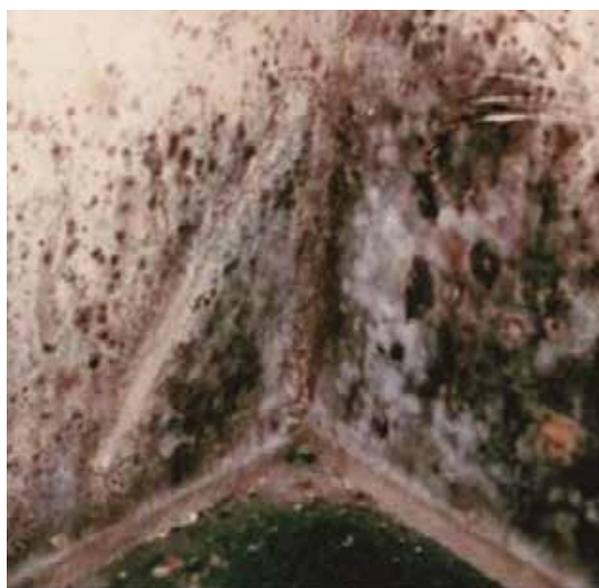
➤ *Stachybotrys* (moho negro) en muro de concreto en sótano inundado.
