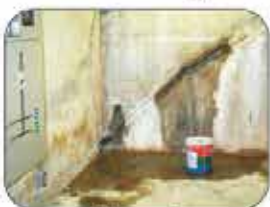
Etap 2 Reparación de Estructura con Radmyx
