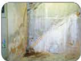
Etap 3 Reparación Exitosa con Radmyx
