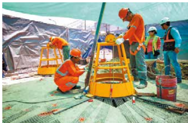
De los 987 pilotes ejecutados alrededor del 50% fueron hechos de forma manual.
