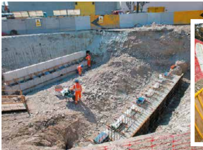
Las vigas de atado unen estructuralmente a los pilotes.
