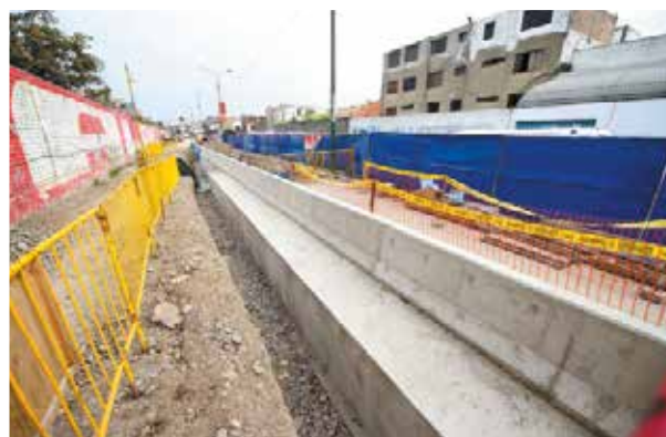
Las vigas de atado unen estructuralmente a los pilotes.
