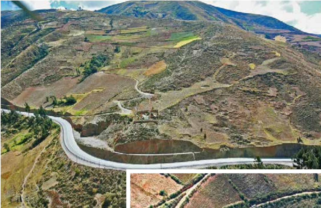
La vía, que cuenta con un ancho de calzada de 6.6 m con bermas de 0.9 a 2 m, se desarrolla sobre terrenos de configuración topográfica ondulada y en su mayoría a media ladera, donde se exhiben algunas quebradas con taludes inestables.
