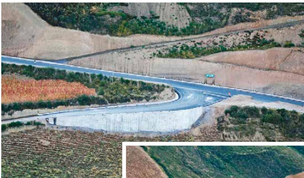
Los muros de contención colocados a lo largo de la vía son de dos tipos: de concreto armado y concreto ciclópeo. Se han ejecutado 1,085 m del primero y 1,057 m del segundo.
