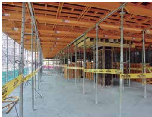
El encofrado CC-4 fue empleado en la ejecución de losas postensadas.
