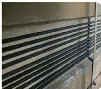
Provee un medio eficiente de reforzamiento estructural, utilizado para controlar las deflexiones, esfuerzos y fisuración del concreto.
