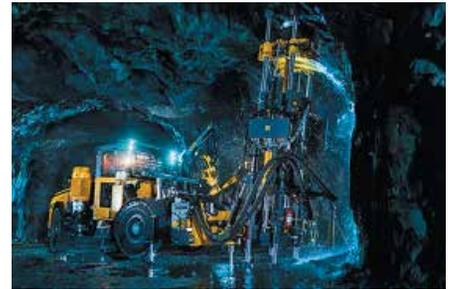
Se trata de la construcción de uno de los túneles más largos de los últimos tiempos, lo que implica un enorme desafío para la ingeniería peruana. Solo en el caso del túnel de trasvase se prevé la presencia de caudales de agua hasta 600 l/s, así como fenómenos de estallidos de rocas en las zonas de mayor cobertura del ducto.
