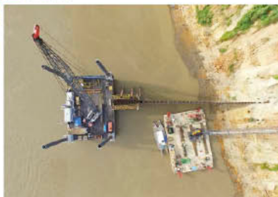
El hincado de los pilotes se realizó con el uso de una plataforma flotante denominada Jack Up (desde el río). Esta última tiene la ventaja que puede elevarse hasta determinada altura y cambiar de lugar.
