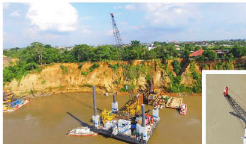
El hincado de los pilotes se realizó con el uso de una plataforma flotante denominada Jack Up (desde el río). Esta última tiene la ventaja que puede elevarse hasta determinada altura y cambiar de lugar.
