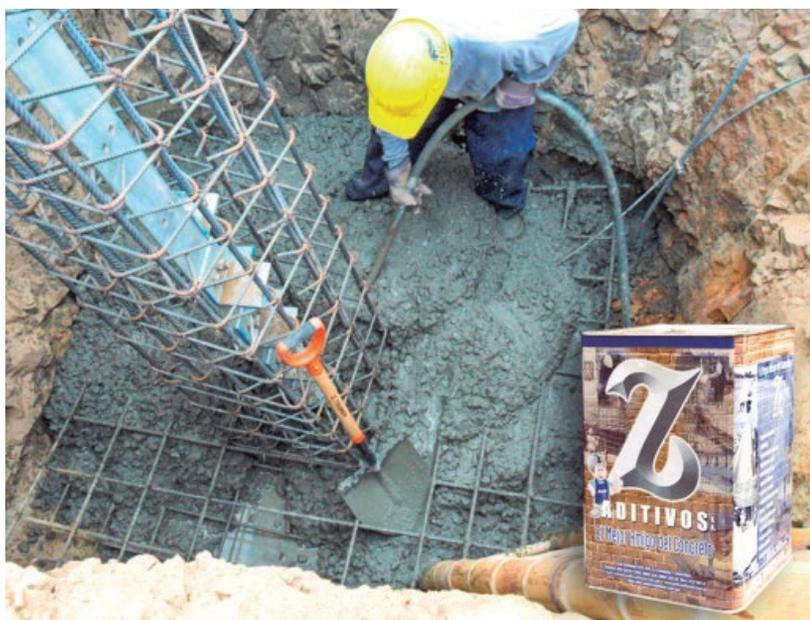
por metro cúbico. Además, evita la formación de cangrejeras y ofrece mayor facilidad de enviar el concreto a alturas. Se puede utilizar en concreto armado -con alta densidad de acero-, premezclados o caravista. Un nuevo producto desarrollado es el Z Fluidizante SR – TR931, de similares características, especialmente indicado para zonas altas, frías y secas.
