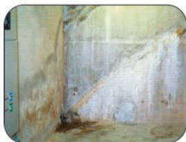
Etap 3 Reparación Exitosa con Radmyx
