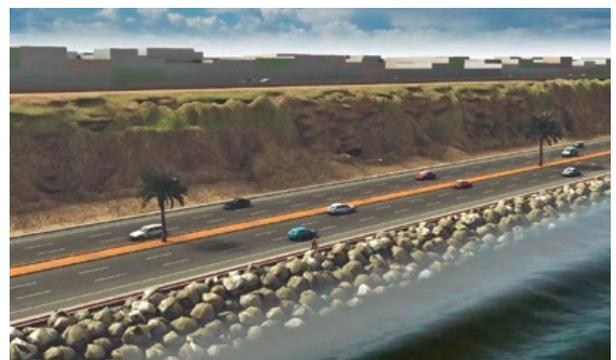
➤ Esta nueva ruta tendrá una extensión de 4.8 km, con una sección transversal de 35 m de ancho. Contendrá seis carriles para el tránsito vehicular: tres de ida y tres de vuelta.
