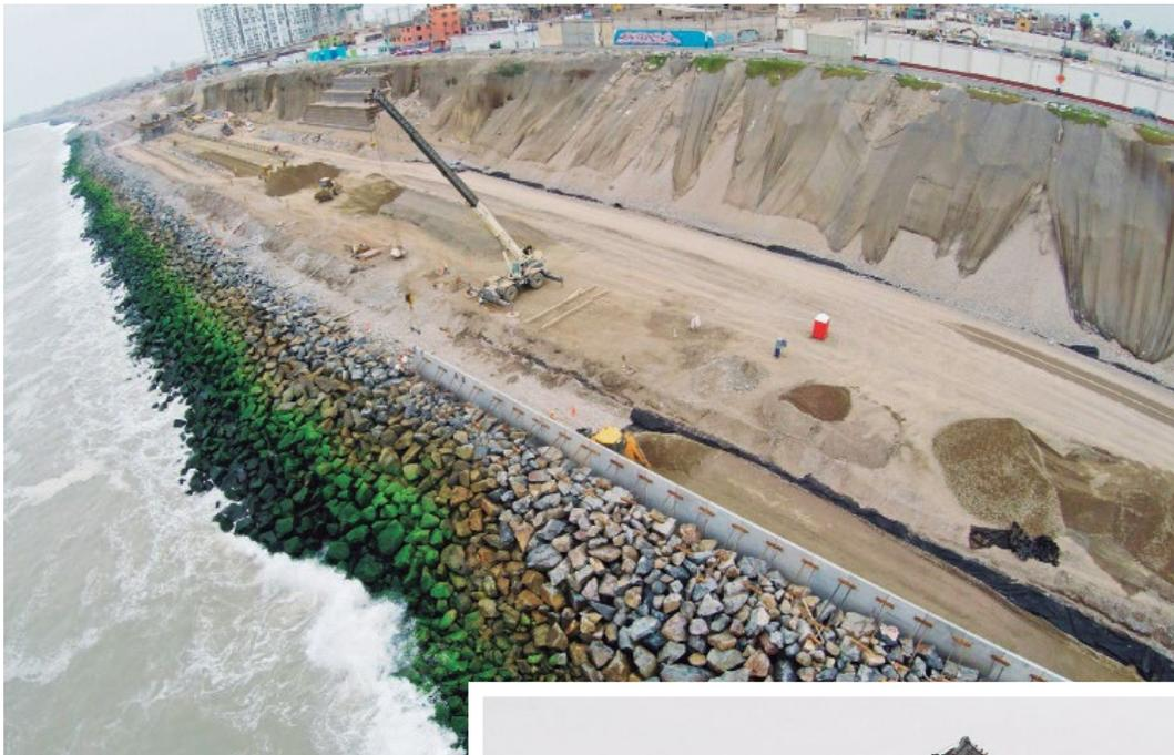
La plataforma está protegida por medio de una defensa marítima formada por un dique de enrocado denominado escollera, el que termina o remata en un muro marino de concreto.
