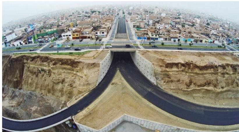
**Eje SR01.** Es un acceso de bajada hacia la Vía Costa Verde de un sólo carril. Este eje está formado por un terraplenado contenido por un muro de suelo reforzado de placas prefabricadas de concreto.
