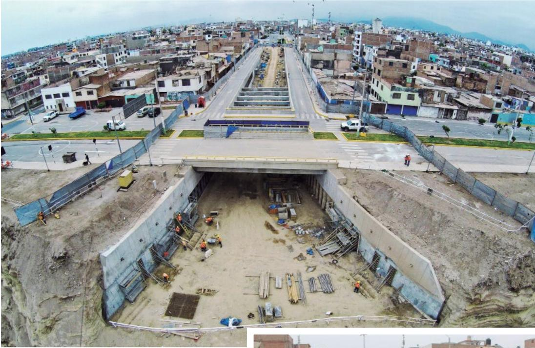
La parte superior de los viaductos fueron los primeros trabajos que se realizaron. Se ejecutaron pantallas a base de pilotes para sostener los taludes en el tramo inicial. Más abajo se emplearon pantallas ancladas al terreno.
