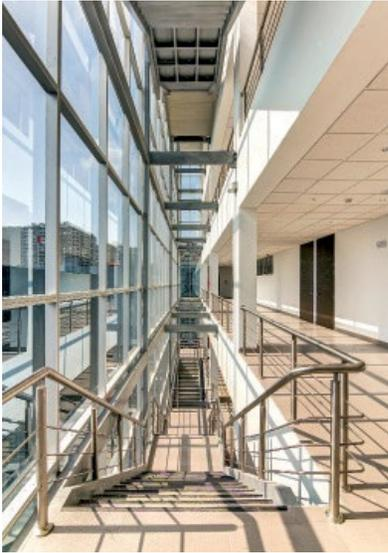
Las escaleras metálicas se sostienen de dos estructuras: una de concreto y otra de metal, que también sirve de soporte al muro cortina.
