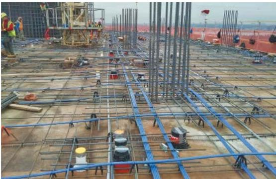
↳ *Las losas postensadas generan un acortamiento significativo de los plazos de ejecución -hasta un 30% más rápido-, además las uniones sencillas y eficientes entre losas, vigas y muros y columnas eliminan problemas de juntas entre estos elementos.*
