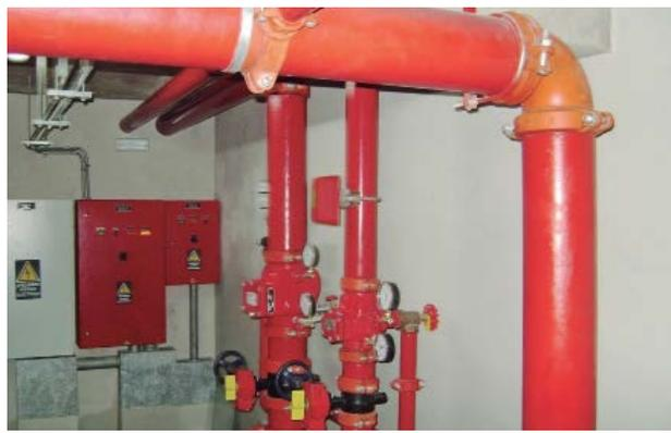
Por elevación de temperatura, en un área determinada se produce la apertura de uno o varios rociadores los cuales, por diferencia de presión, iniciarán la descarga de agua para extinguir el fuego.
