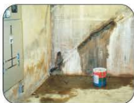
Etap 2 Reparación de Estructura con Radmyx
