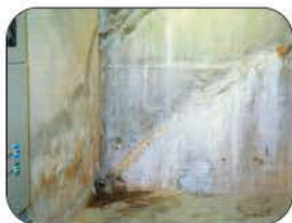
Etap 3 Reparación Exitosa con Radmyx
