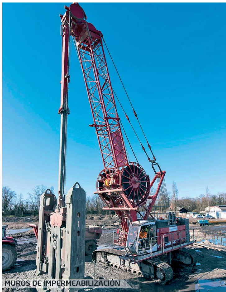
VIBROFLOTACIÓN
