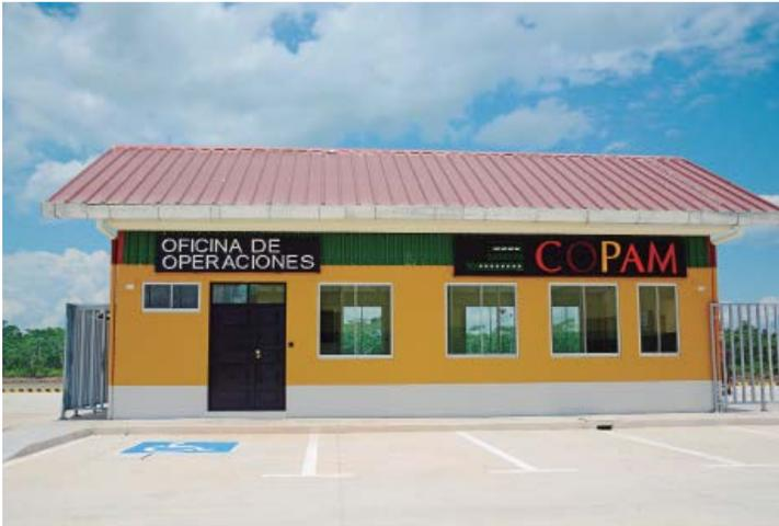
Edificio de Operaciones es una nave con cerramientos perimetrales de ladrillo con columnas y vigas de amarre de concreto hasta  $h=2.90$  m. Sobre ella se asienta una estructura metálica techada con paneles termo-acústicos.
