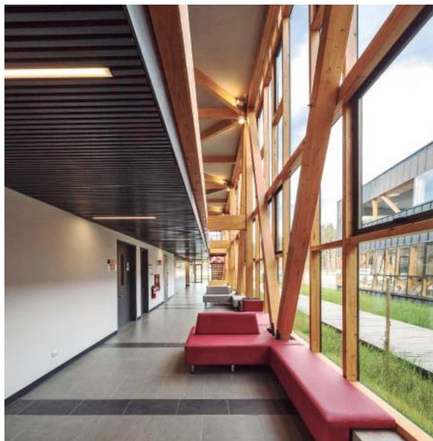
*El modelamiento de los elementos de madera que se diseñaron fueron cortadas en un proceso llamado mecanizado, donde cada una de las piezas estructurales se montaron y se confeccionaron para su instalación en obra.*
