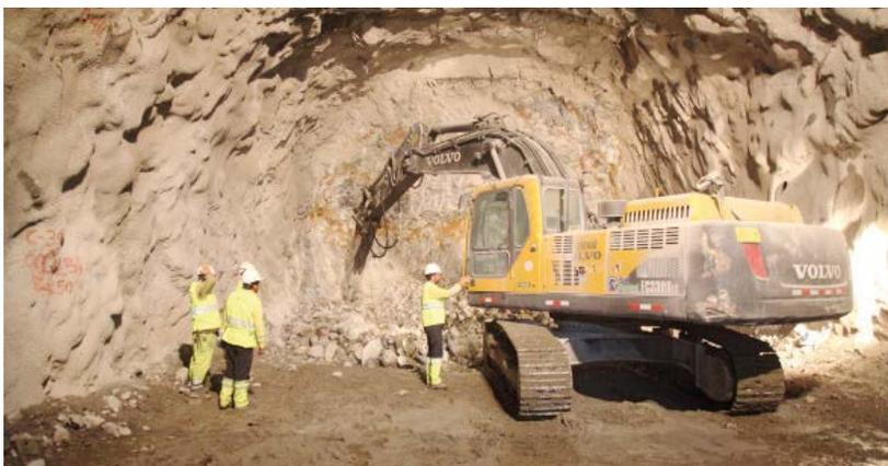
Como parte del proceso de definición de la sección interna mínima proyectada se realizó un estimativo del espacio requerido para ventilar naturalmente el túnel requiriendo tráfico bidireccional, en un área de servicio promedio para 60 m<sup>2</sup>.
