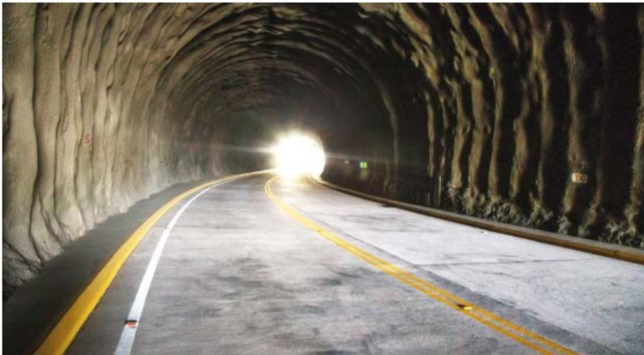
El túnel tiene dos carriles de 3.60 m de ancho cada uno, sobre ancho de calzada (berma) de 0.40 m a cada lado y veredas (andenes) de 1 m de ancho.
