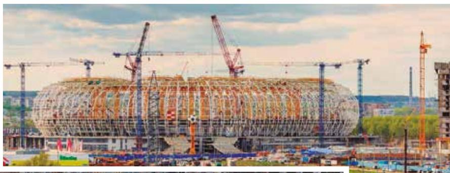
En el Mordovia Arena se realizaron, entre otros, trabajos de montaje de la estructura metálica, techo del estadio, la fachada y gradas provisionales.
