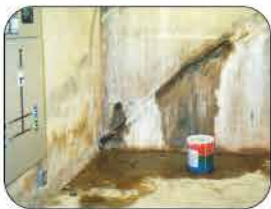
Etap 2 Reparación de Estructura con Radmyx
