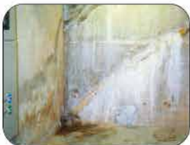
Etap 3 Reparación Exitosa con Radmyx
