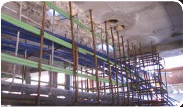
Utilizado para incrementar la capacidad de columnas y vigas.
