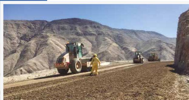
En los trabajos de movimiento de tierra se ha ejecutado desbroces, excavaciones, terraplenes, mejoramientos y explotación de canteras.
