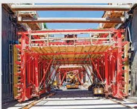
VARIOKIT para la construcción de túneles.
