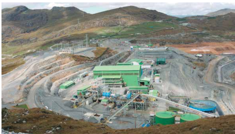
La molienda es la segunda etapa del proceso donde el mineral proveniente del chancado es mezclado con agua para ingresar al Molino SAG, realizando la disminución de tamaño de 10 pulg a 0.5 pulg.
