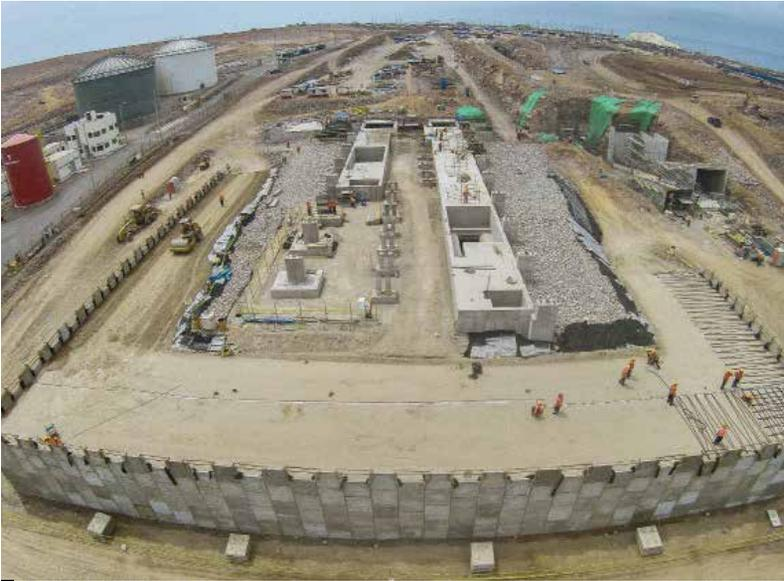
Inicialmente el mineral ingresará al Terminal Portuario por vía férrea y por vía terrestre a uno de los cuatro edificios de descarga, cada uno de ellos posee al menos un Feeder de 350 TPH y una línea transportadora.
