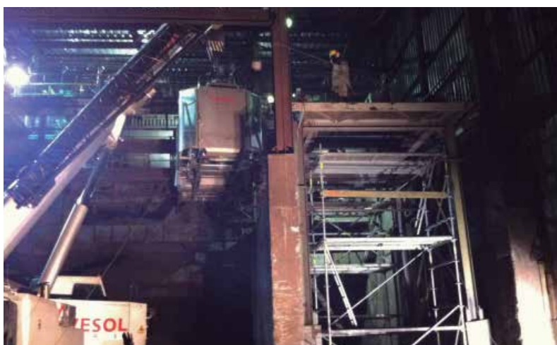
En los últimos meses del 2014 se reemplazó al actual chancador primario Fuller Traylor 1,200 por 900 mm por uno de mandíbula Sandvik CJ412.
