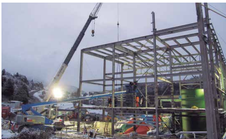
El proyecto de ampliación del sector molienda consistió en el montaje electromecánico de un molino de bolas y equipos asociados, incluyendo la ampliación de la nave de molienda, edificio estructural desde el eje 7 al 11, entre otras. Gentileza Echeverría Izquierdo Montajes Industriales.
