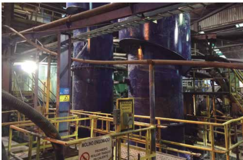
En el área de flotación se están instalando dos columnas de flotación que mejorarán la etapa de limpieza de los concentrados de zinc y oro. Gentileza Minera Nyrstar El Toqui.
