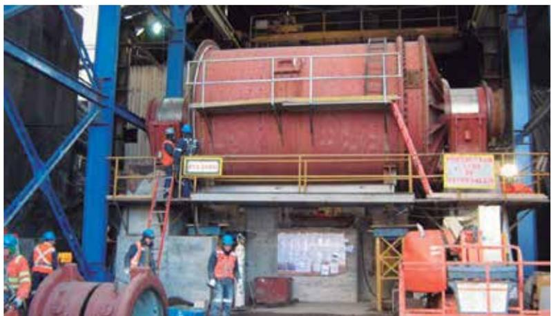
Con todo el sistema de giro terminado y aceptado se procede al grouteado del sistema motor-piñón y finalmente, se colocan las corazas del shell y tapas. Gentileza Echeverría Izquierdo Montajes Industriales.
