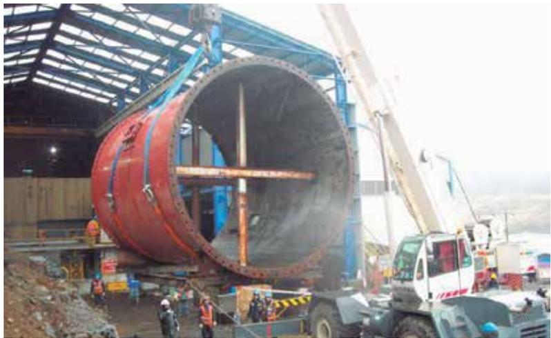
La instalación del shell (carcasa del molino), el cual se monta sobre una estructura metálica provisoria que se fabrica en terreno para desarrollo de la original. Gentileza Echeverría Izquierdo Montajes Industriales.
