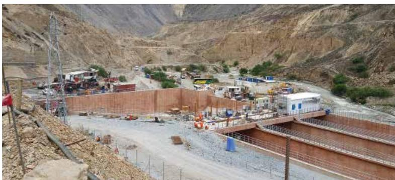
El desarenador se ubica en la margen izquierda del río. Está conformado por tres naves.
